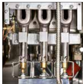
Particolare bruciatori inox a gas ad alto rendimento Detail of high performance stainless steel gas burners. Détail des brûleurs en acier inox à gaz à rendement élevé Detalle quemadores inox a gas de alto rendimiento
